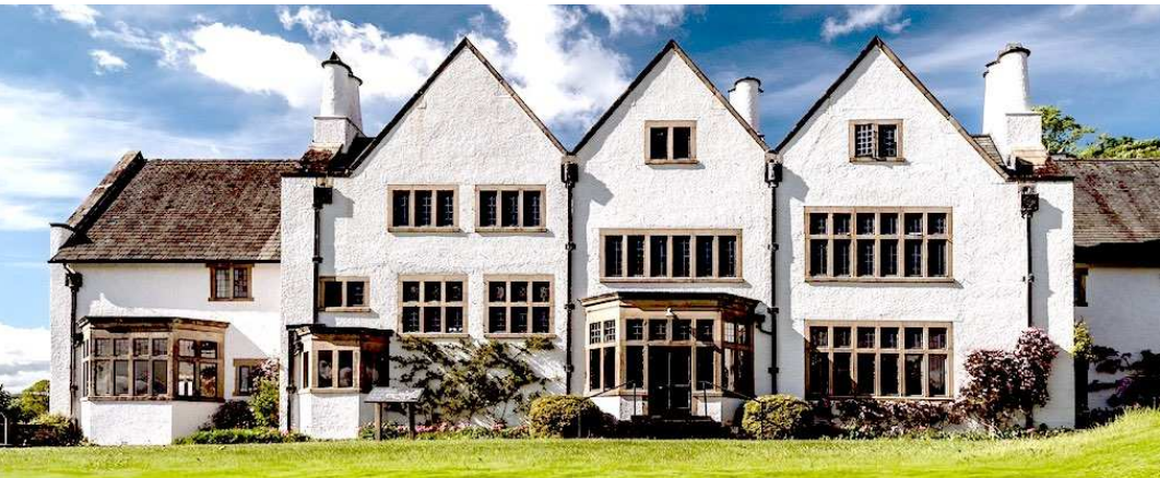
Arts-and-Crafts-Stil: Blackwell House (1898–1900) verfügt gleich über drei Bay Windows . Lake District, England. Architekt: Hugh Baillie Scott.
